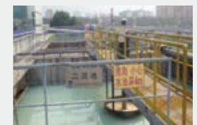
化学処理式COD除去施設
