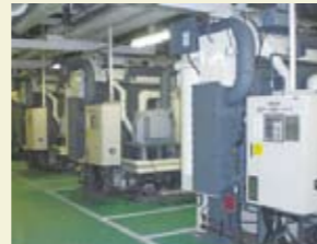
吸収式冷凍機の更新
