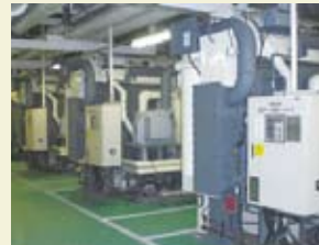
吸収式冷凍機の更新
