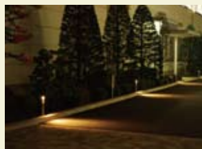
構内LED照明
