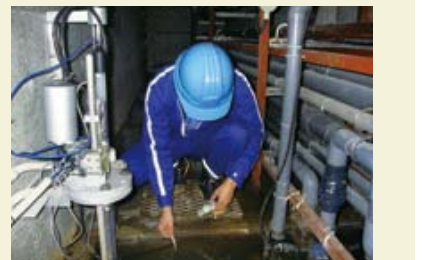
共同溝排水マスでのpHチェック
