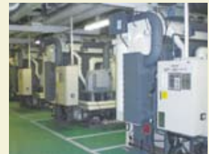
吸収式冷凍機の更新
