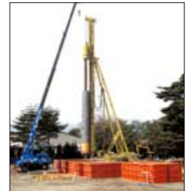
地下水拡散防止対策工事状況
