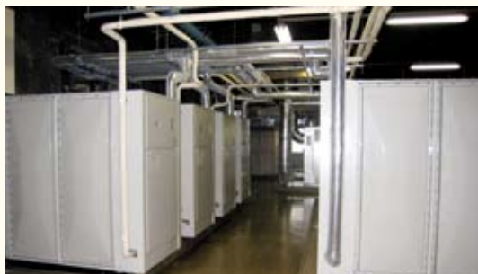
蓄熱式ヒートポンプシステム
