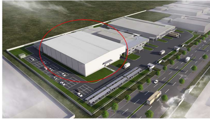
ベトナム工場に新設される加工棟（赤枠内）
