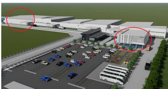
工作機械事業タイ工場全景（右手前がショールーム棟、左奥が増床部分）
