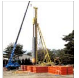
地下水拡散防止対策工事状況
