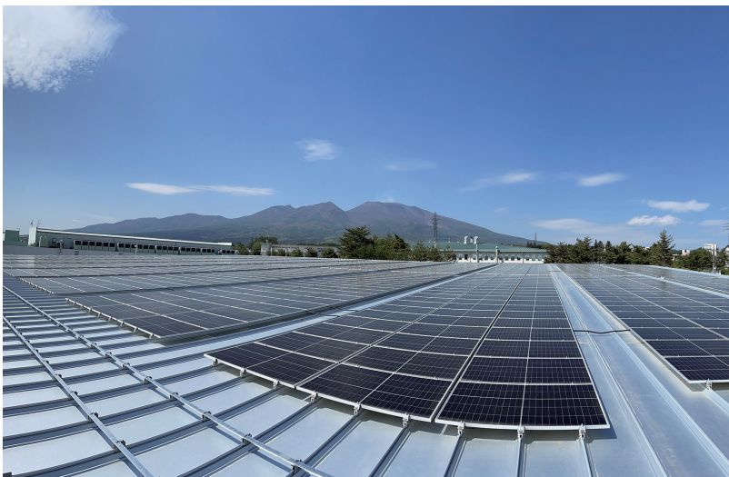
工作機械事業(シチズンマシナリー)の軽井沢本社工場に設置されている太陽光パネル
